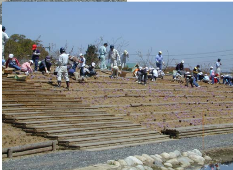
地元小学生による法面緑化(シバ桜)状況
